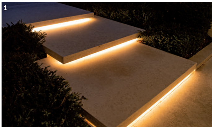
1 Schwebende Stufen, unterleuchtet mit LED-Band.
